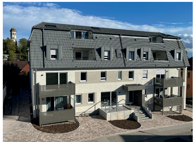
General-Sigel-Str. 8, Neubau im Oktober 2023
